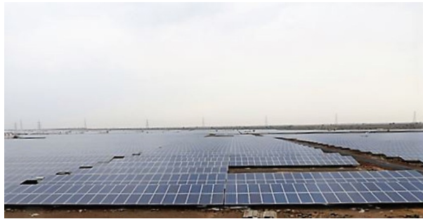
大規模太陽光発電所
