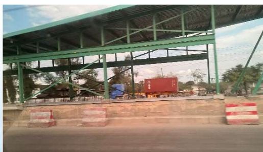
バス専用レーンを 建設中
