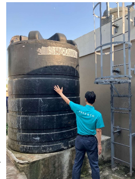
普段水道水を溜めるタンク
